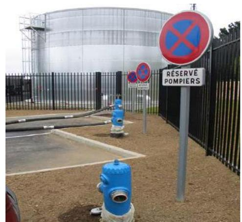
*Réserve d'eau incendie aérienne de 720 m<sup>3</sup> équipée de 3 poteaux d'aspiration de 150 mm*
