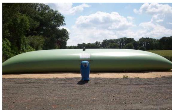
Les réserves d'eau incendie enterrées sont utilisables par le biais de colonnes ou de bouches d'aspiration, dont le nombre et le type dépendent directement de la capacité en m<sup>3</sup>.
