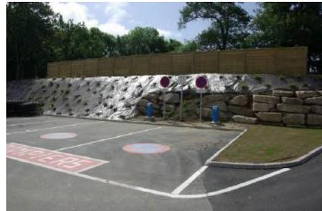
*2 Plates formes d'aspiration sur une réserve d'eau équipée de deux poteaux d'aspiration de 100 mm*
