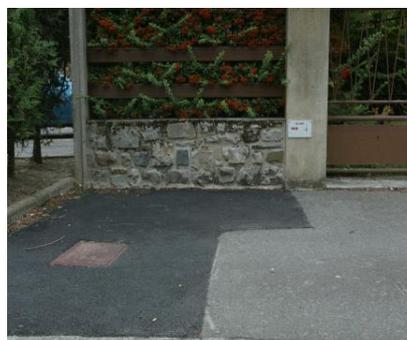
*Cette plaque indique qu'une bouche incendie de 100 mm (BI DN 100), raccordée sur une canalisation de 150 mm est implantée à 3 m devant la plaque et à 1,8 m sur la gauche.*
