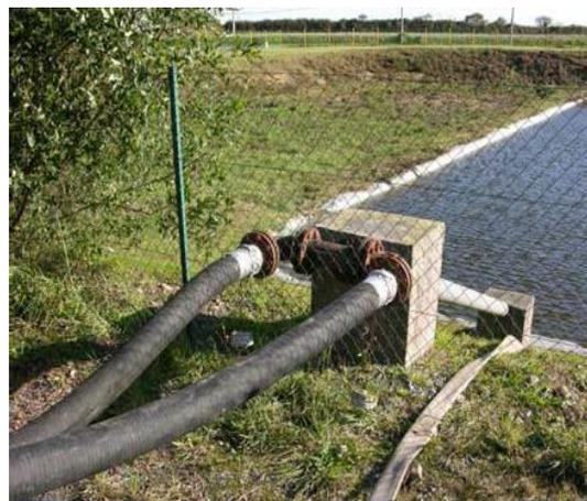
*Réserve d'eau ouverte avec 1 colonne de 150 mm alimentant 2 sorties de 100 mm*
