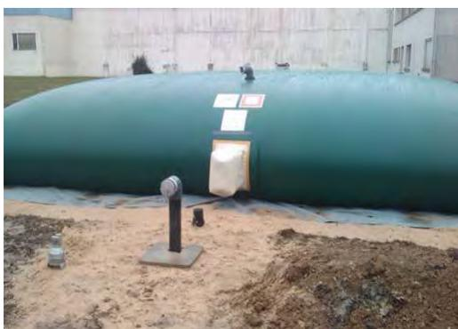
Réserve d'eau souple de 120 m<sup>3</sup> utilisable par le biais d'un poteau d'aspiration
