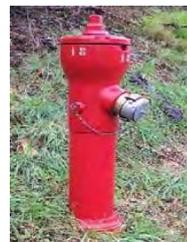
Poteau incendie de 80mm avec une sortie de 65mm
