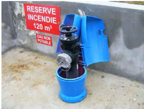
*Poteau d'aspiration de 100 mm muni d'une seule sortie de 100 mm et d'un volant de manœuvre*
