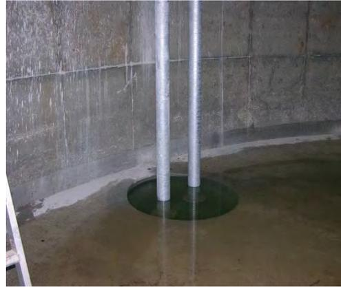
*Fond de la cuve avec crépine sous le niveau le plus bas de l'eau*
